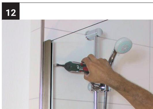
Schrauben Sie den Adapter locker an, damit das Glas Halt hat.
