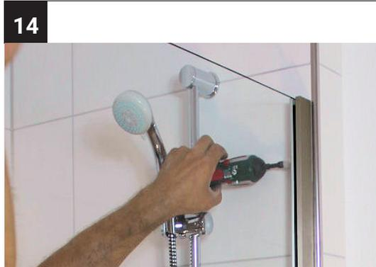
Schrauben Sie den Adapter am anderen Seitenprofil locker an.
