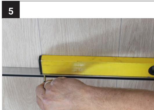
Halten Sie das Profil an die Gerade an und zeichnen die Bohrlöcher mit einem Stift an.
