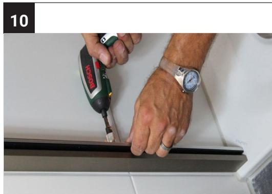
Schrauben Sie den Adapter locker an den Grundkörper.
