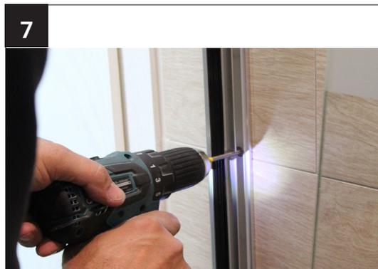
Verwenden Sie Senkkopfschrauben 5x60 mit Vollgewinde.
